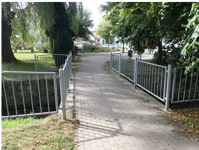
Celkový pohled na lávku z pravobřežního předpolí
