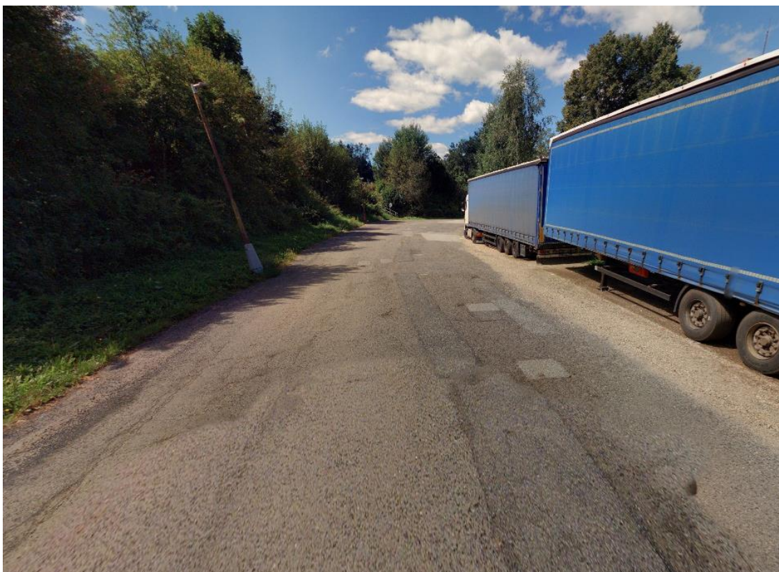
FOTO Č.3 – VÝHLED Z VOZIDLA VLEVO (PARKOVÁNÍ KAMINOU BUDE ZRUŠENO)
