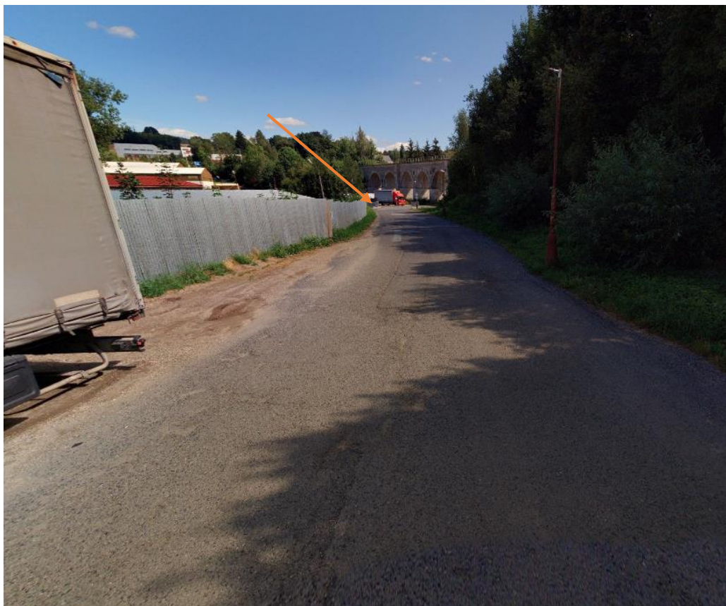
FOTO Č.6 – POHLED NA SJEZD PŘI PŘÍJEZDU ZPRAVA (PARKOVÁNÍ KAMINOU BUDE ZRUŠENO)
