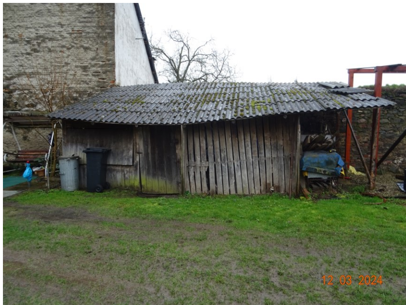
Obr. č. 1 – stavba č. 1
