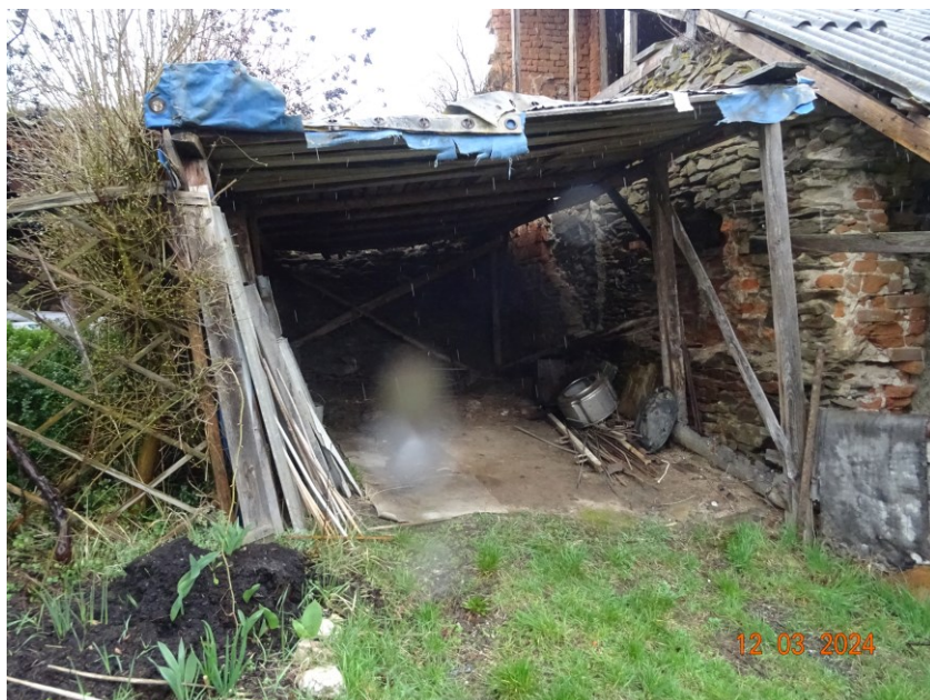
Obr. č. 5 – stavba č. 8
