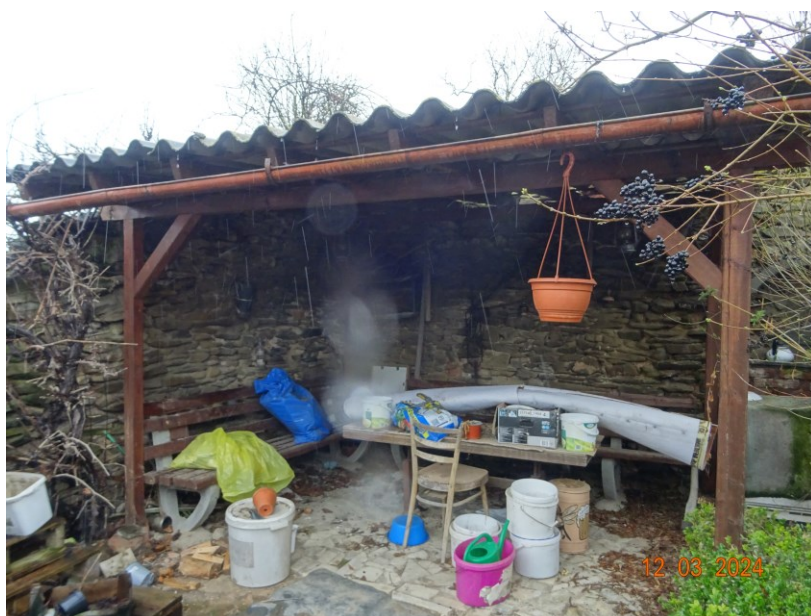
Obr. č. 6 – stavba č. 9
