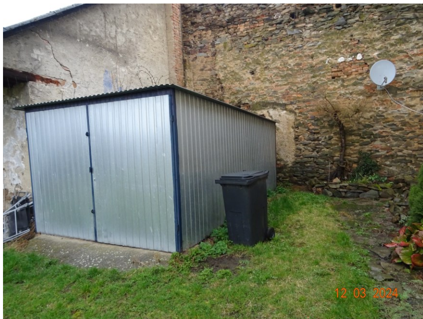
Obr. č. 4 – stavba č. 7
