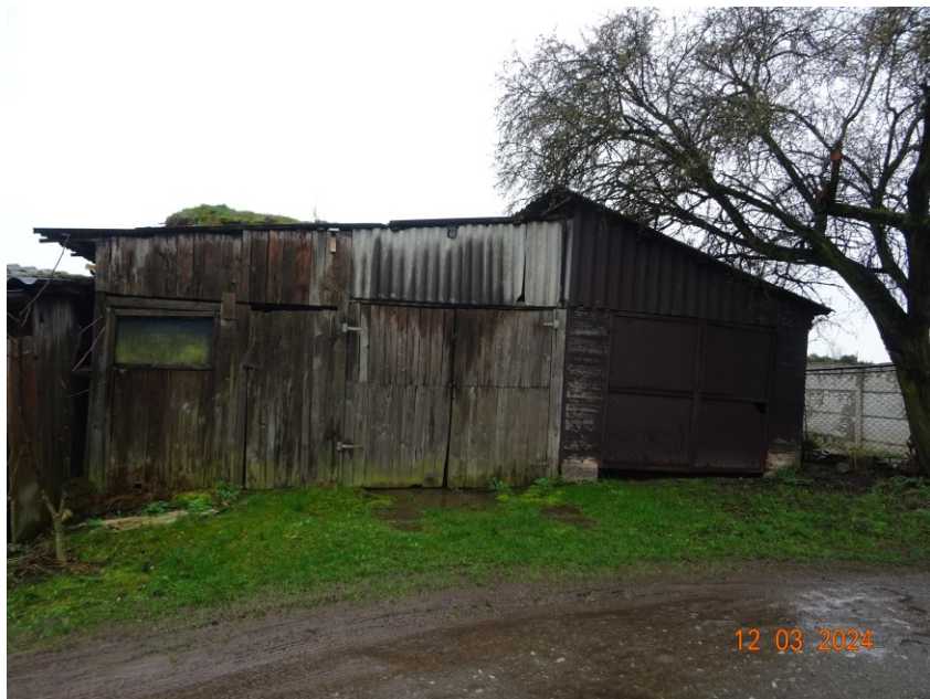
Obr. č. 3 – stavba č. 4 a 5
