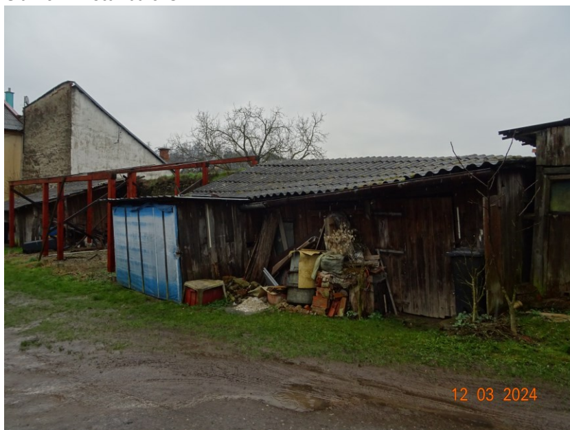
Obr. č. 2 – stavba č. 3
