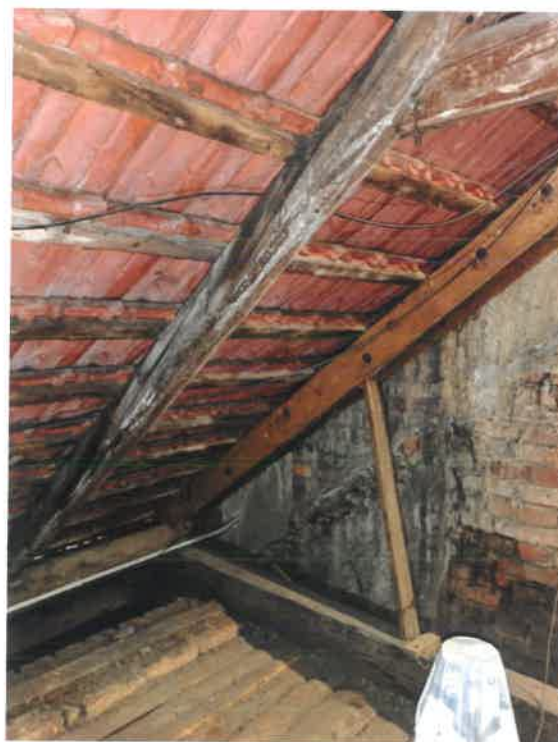
Napadení krokve dřevokaznou plísní
