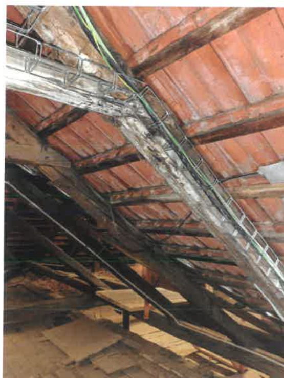
Napadení krokve dřevokaznou plísní
