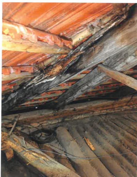
Napadení krokve dřevokaznou houbou
