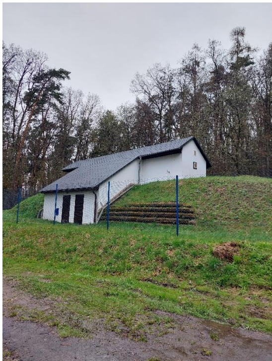
Vodojem horního tlakového pásma Dubicko
