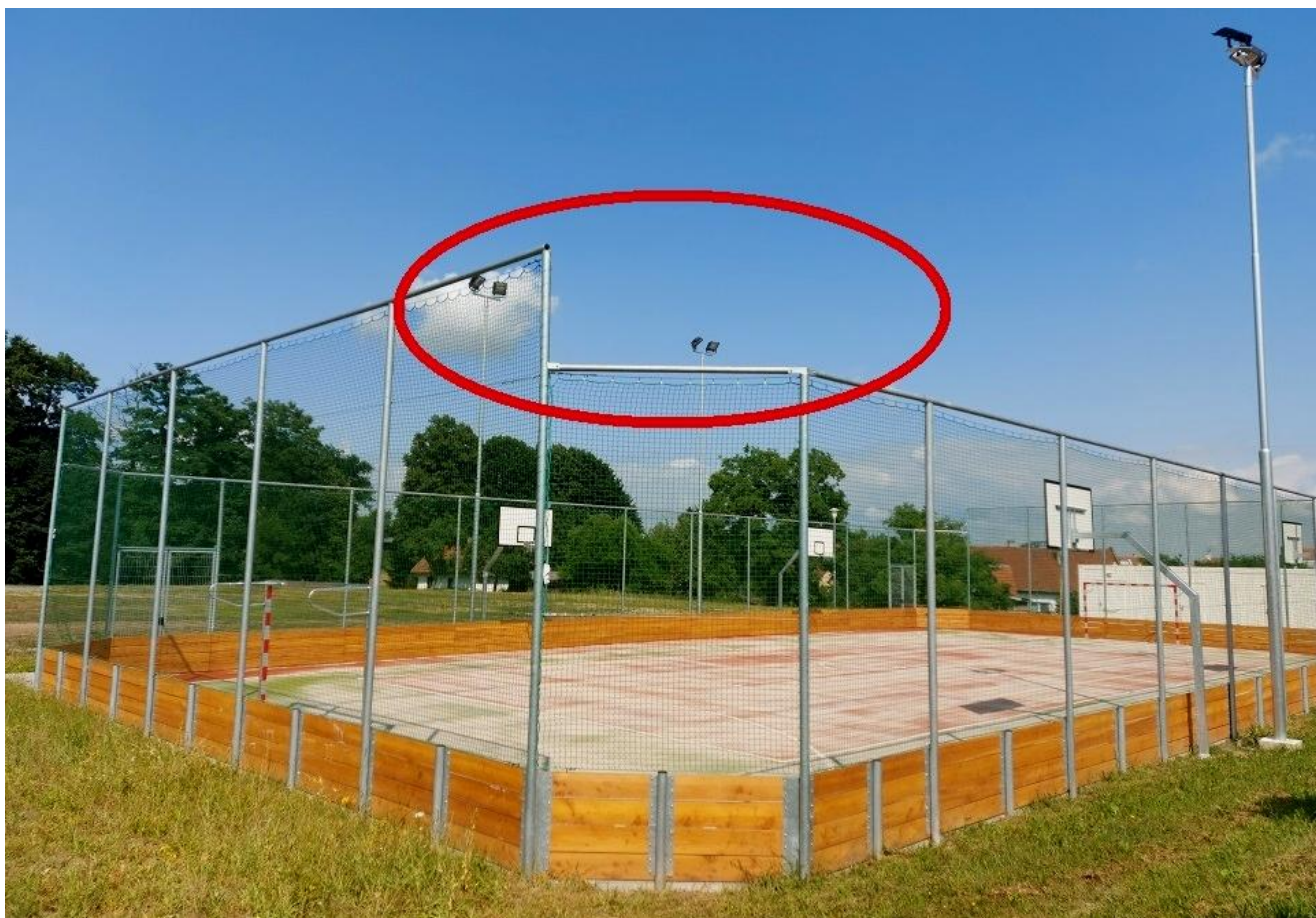
FOTODOKUMENTACE PROVEDENÍ HORNÍHO ZTUŽENÍ – chybně provedená ztužující šikmina oplocení
