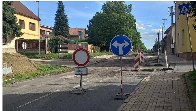
Obrázek 22 19. září sundání vrchní vrstvy asfaltu, pohled na křižovatku ulice Hájecká
