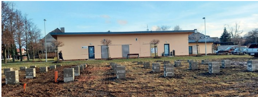
Obrázek 8 připravené pilíře na stavbu kontejnerové školky
