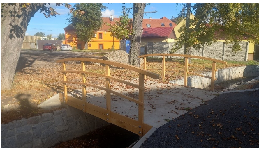
Obrázek 13 Původní betonový mostek obložený dřevem
