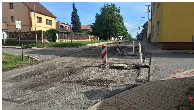
Obrázek 21 19. září začátek rekonstrukce, pohled na křižovatku ulice Hájecká
