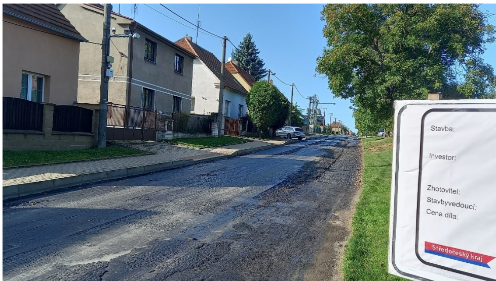
Obrázek 23 30. září zarovnání povrchu před položením asfaltu, pohled z křižovatky ulice Nová
