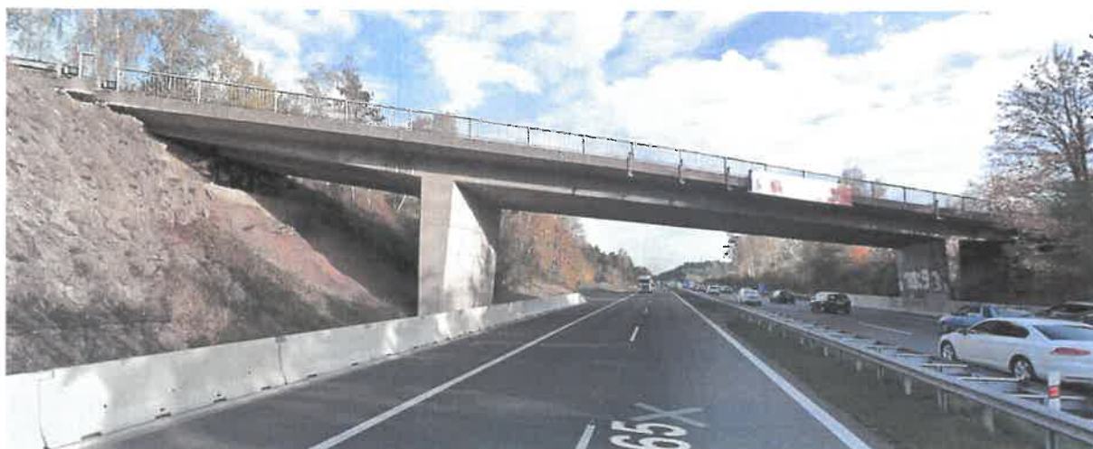
pohled na most ve směru od Prahy, pravá strana mostu (zdroj google.maps.cz)
