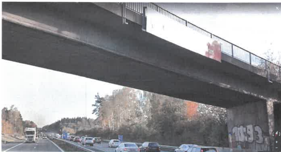
2. pole s rámovou konstrukcí, pravá strana mostu (zdroj google.maps.cz)
