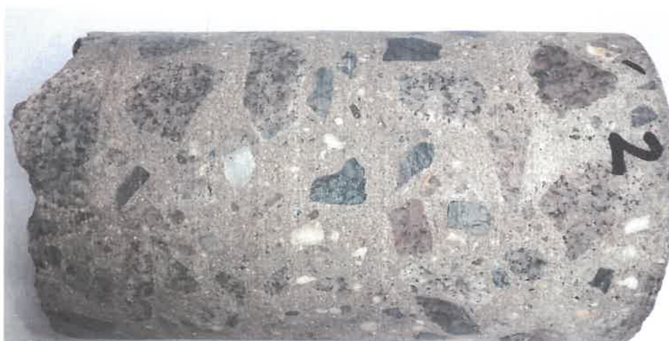
Vývrt V2 - nosná konstrukce, střední pole
