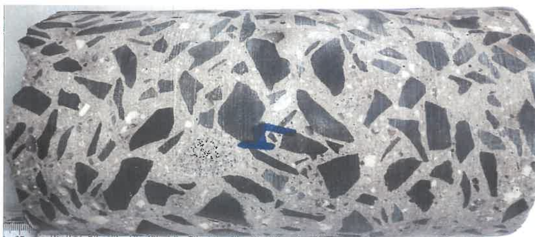
Vývrt V4 - nosná konstrukce, 1. pole
