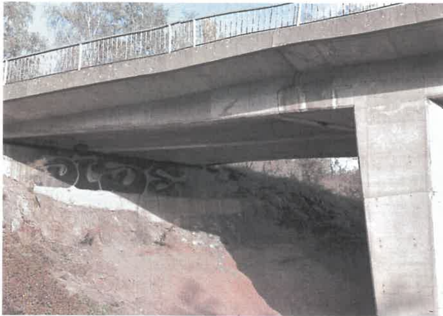
1. pole s trámovou konstrukcí a napojení rámu středního pole, pravá strana mostu (zdroj google.maps.cz)
