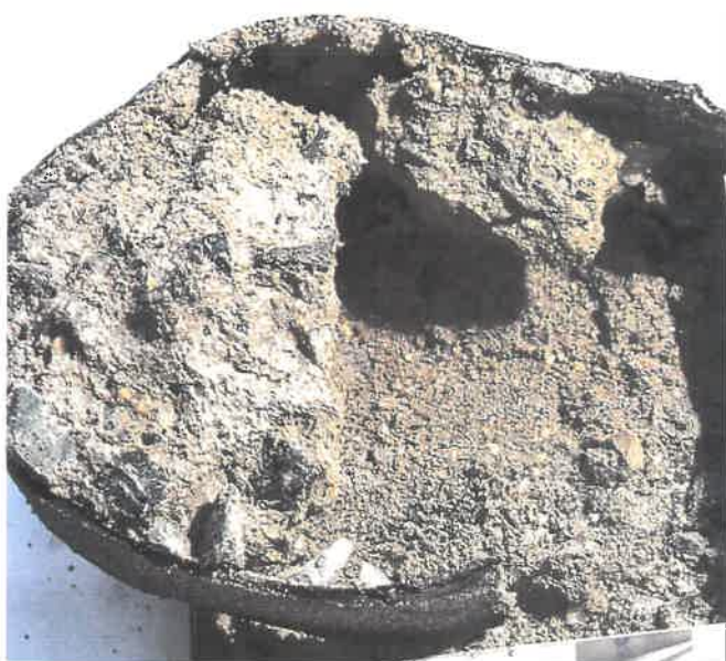
CHRL 2 - nosná konstrukce, 1. pole
