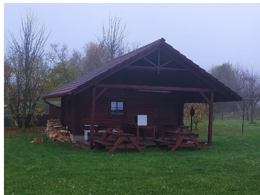
Zázemí sportoviště - srub
