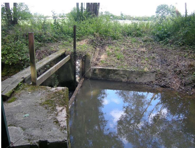
Obr.3 – pohled na návodní stranu hradící konstrukce z levého břehu – stávající stav
