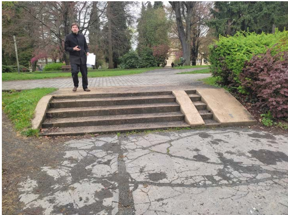
stávající schodiště s rampou u zastávky
