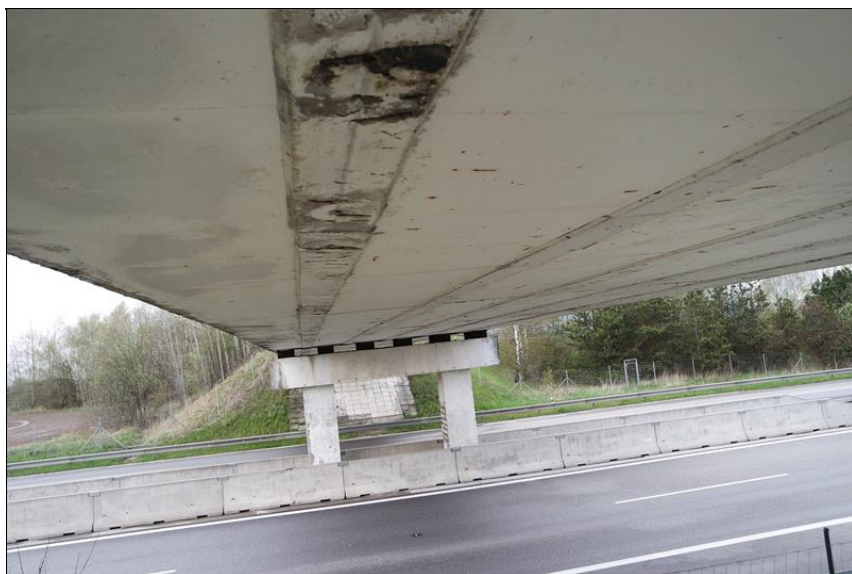
Podhled nosné konstrukce v poli 1.
