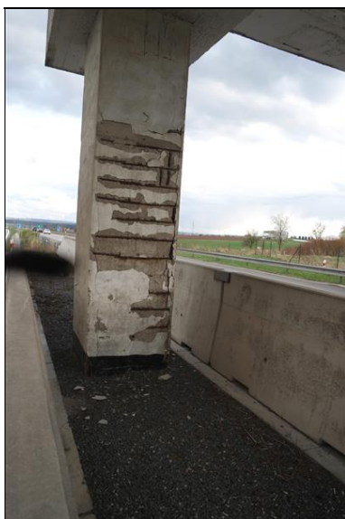
Pravá stojka pilíře P2 - poruchy krycí vrstvy a koroze výztuže.
