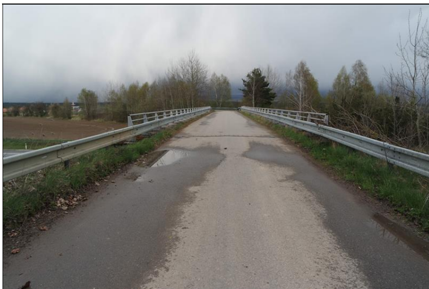
Pohled na most po směru staničení.
