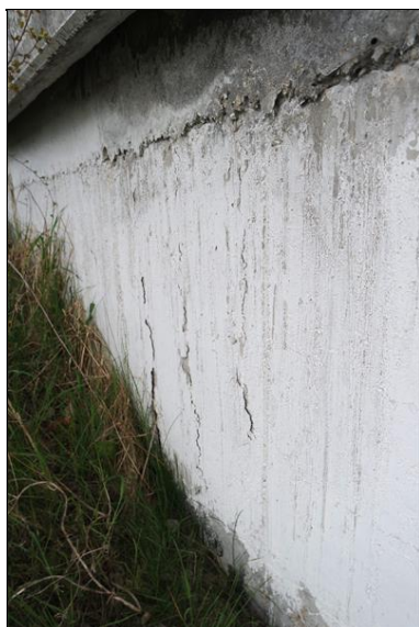
Poruchy krycí vrstvy na pravém křídle opěry 01.
