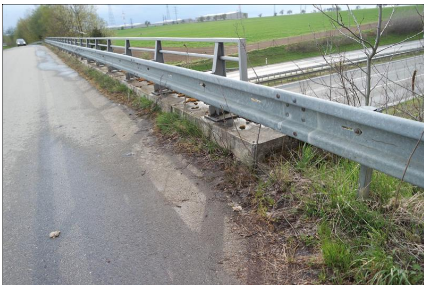
Příčná trhlina ve vozovce na předpolí opěry 03.
