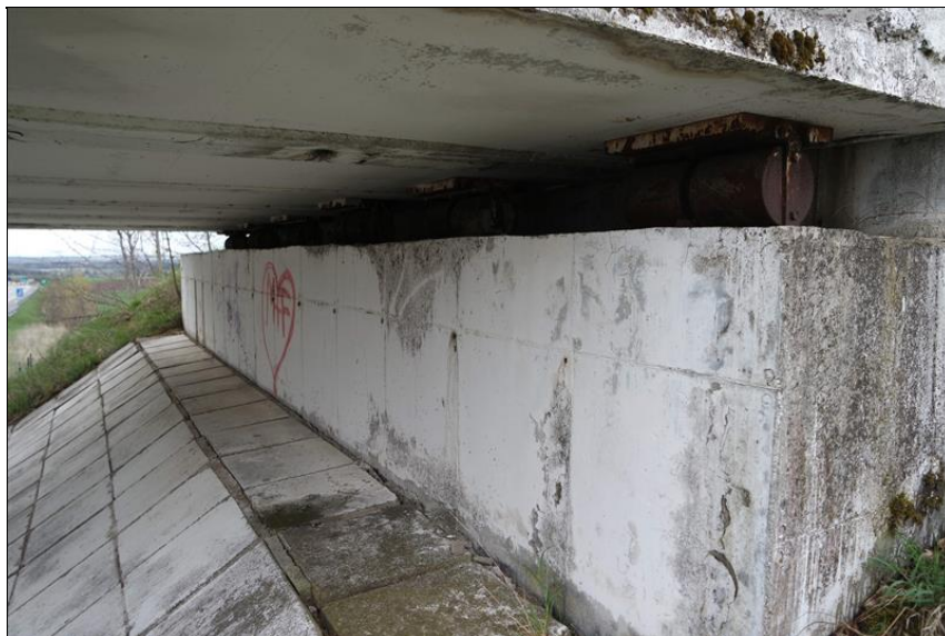
Poruchy krycí vrstvy na pravém křídle opěry 01.
