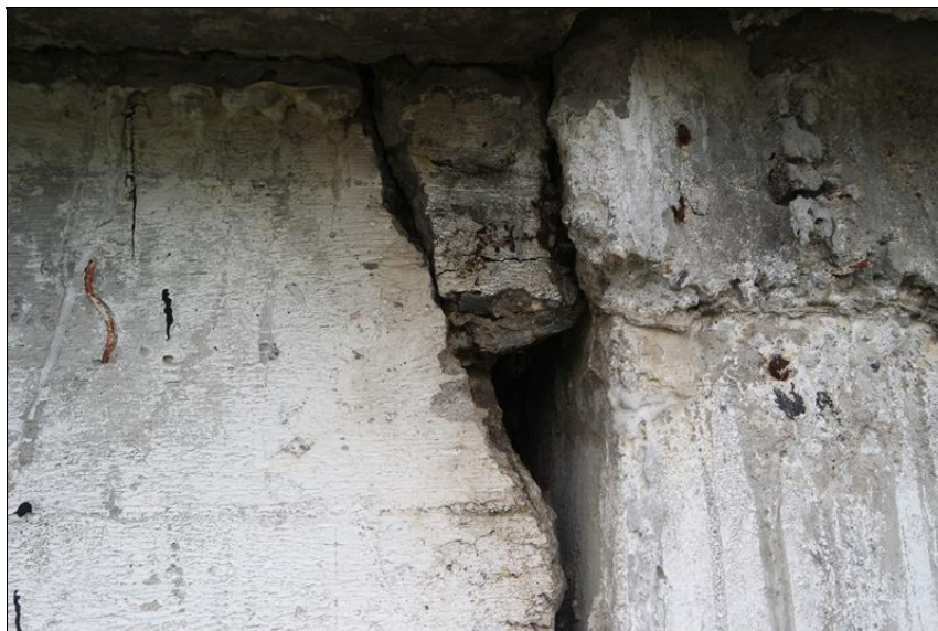
Separovaná dobetonávka čela nosníku v poli nad opěrou 01.
