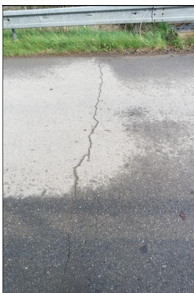
Příčná trhlina ve vozovce na předpolí opěry 03.
