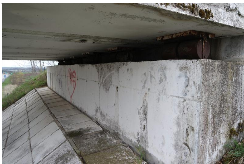
Pohled na opěru 01.
