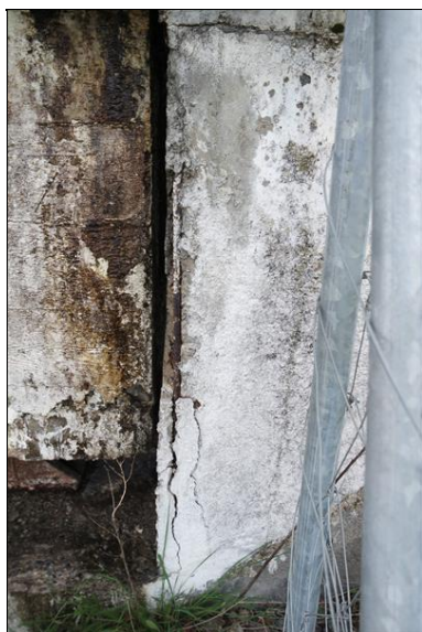
Poruchy krycí vrstvy a koroze výztuže závěrné zídky na opěře 03 vpravo.
