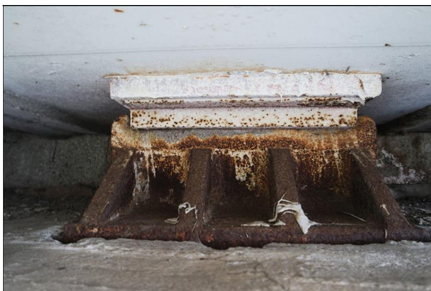
Ložisko na opěře 03.
