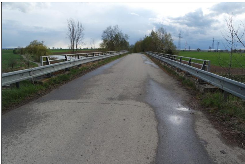
Pohled na most proti směru staničení.
