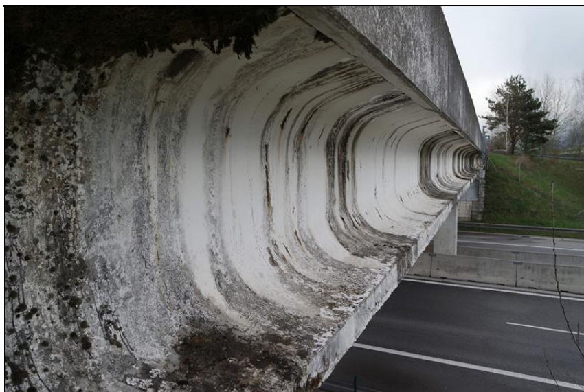
Pohled na pravý bok nosné konstrukce.
