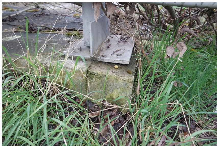
Koncový sloupek zábradelního svodidla nad opěrou 01.
