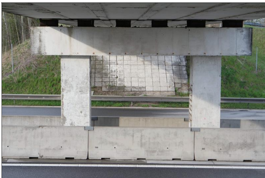
Pravá stojka pilíře P2 - poruchy krycí vrstvy a koroze výztuže.
