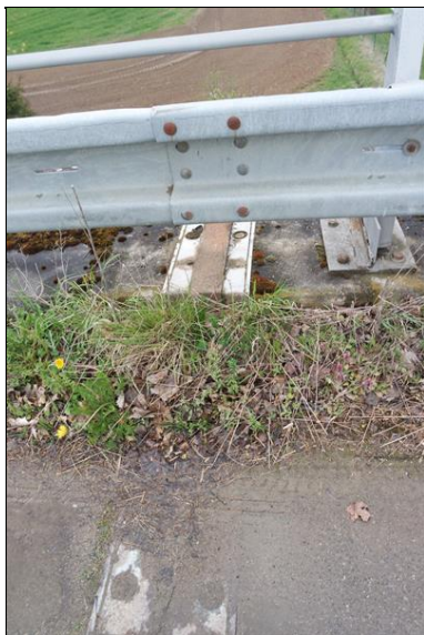
Mostní závěr nad opěrou 01.
