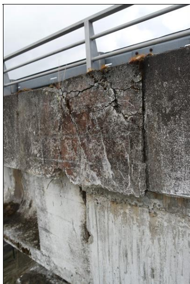
Drcení monoliticky dobetonované římsy u mostního závěru nad opěrou 01.
