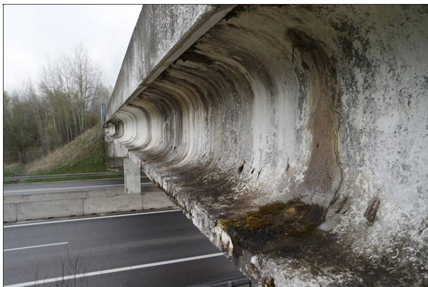
Pohled na levý bok nosné konstrukce.
