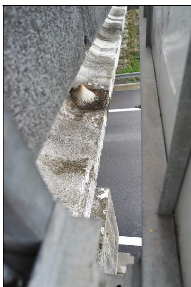
Silné inkrustace na levém boku nosné konstrukce v poli 1 u P2.
