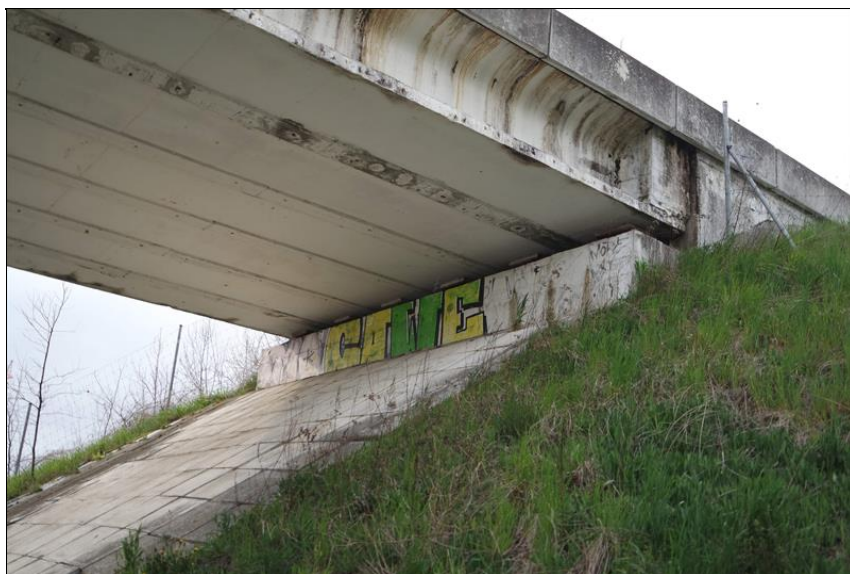
Poruchy krycí vrstvy a koroze výztuže závěrné zídky na opěře 03 vpravo.
