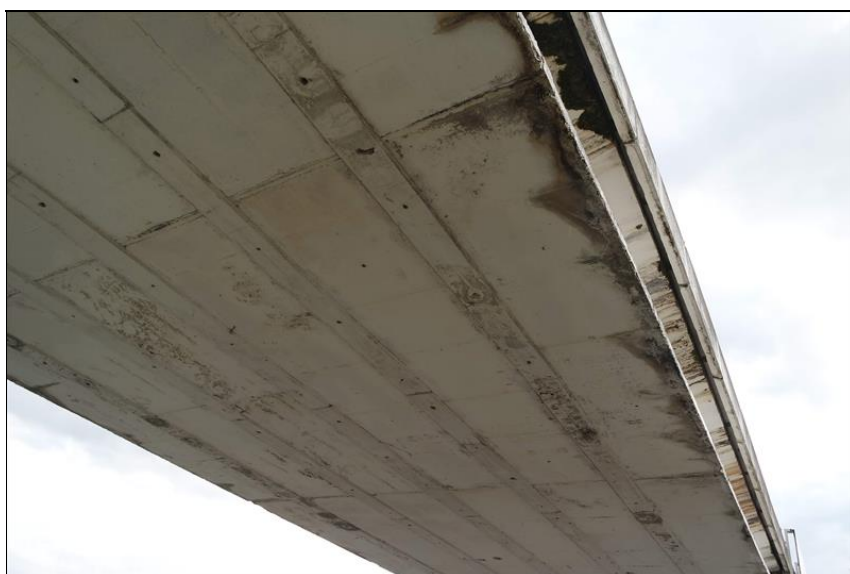
Podhled nosné konstrukce v poli 2.
