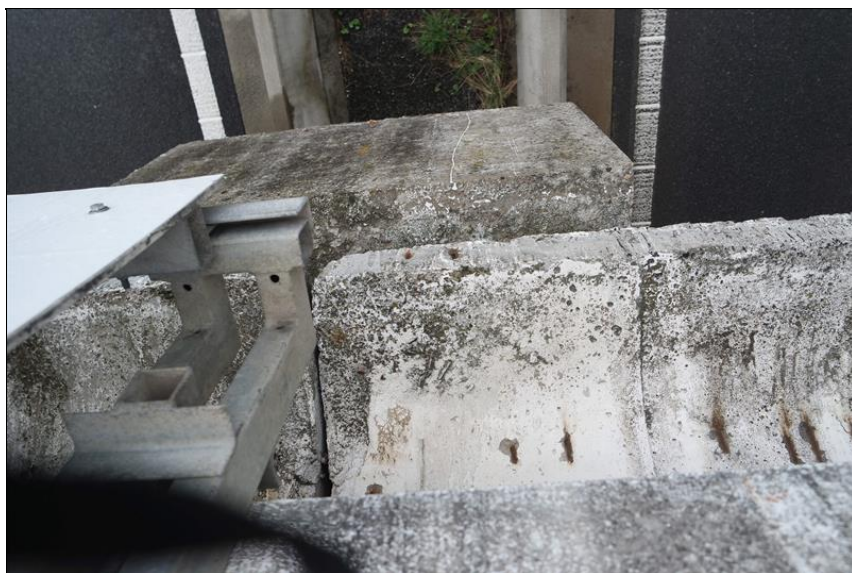
Silné inkrustace na levém boku nosné konstrukce v poli 1 u P2.
