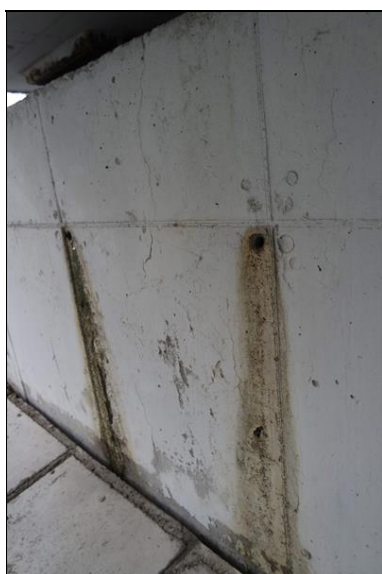
Výtoky z odvodňovacích trubiček úložného prahu.
