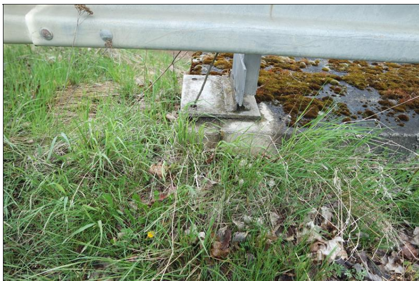
Koncový sloupek zábradelního svodidla nad opěrou 01.
