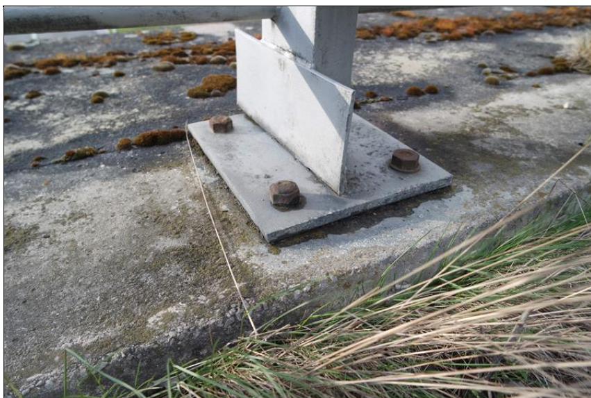
Kotvení svodidel.
