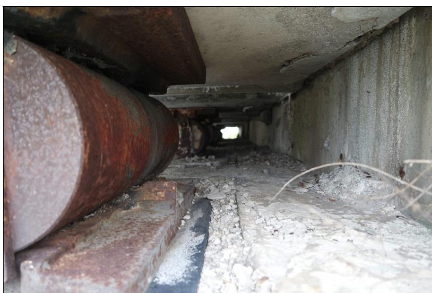
Úložný práh opěry 01.
