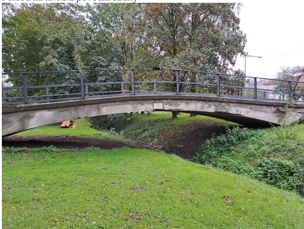
Pohled na lávku z povodňové strany.
