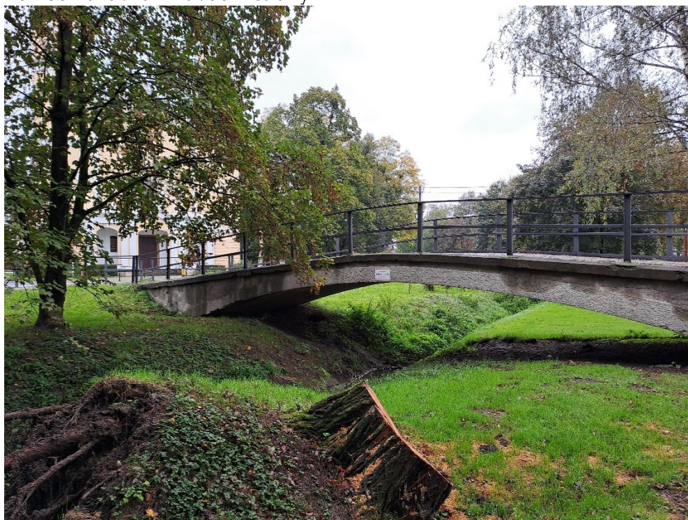
Pohled na lávku z návodní strany.
