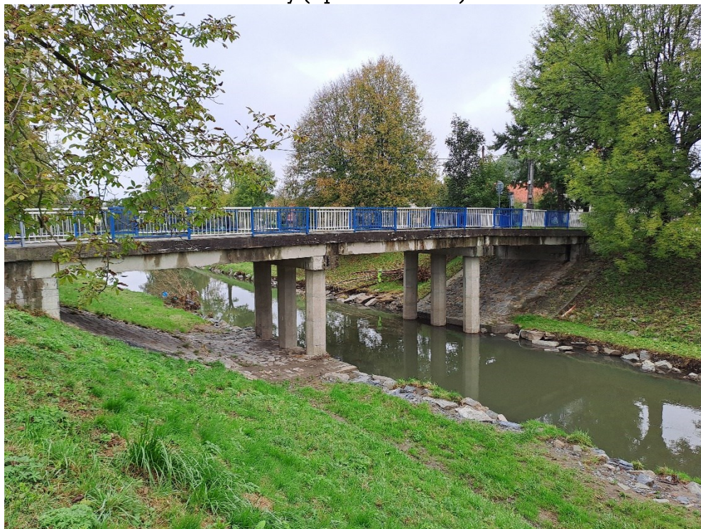
Pohled na most z návodní strany (z pravého břehu)
