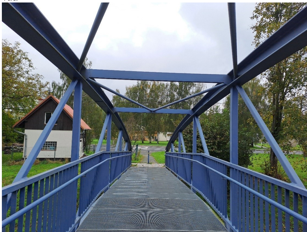
Pohled na ztužení horních pásů příhradových nosníků NK (směrem od OP1 k OP2) – bez vad
