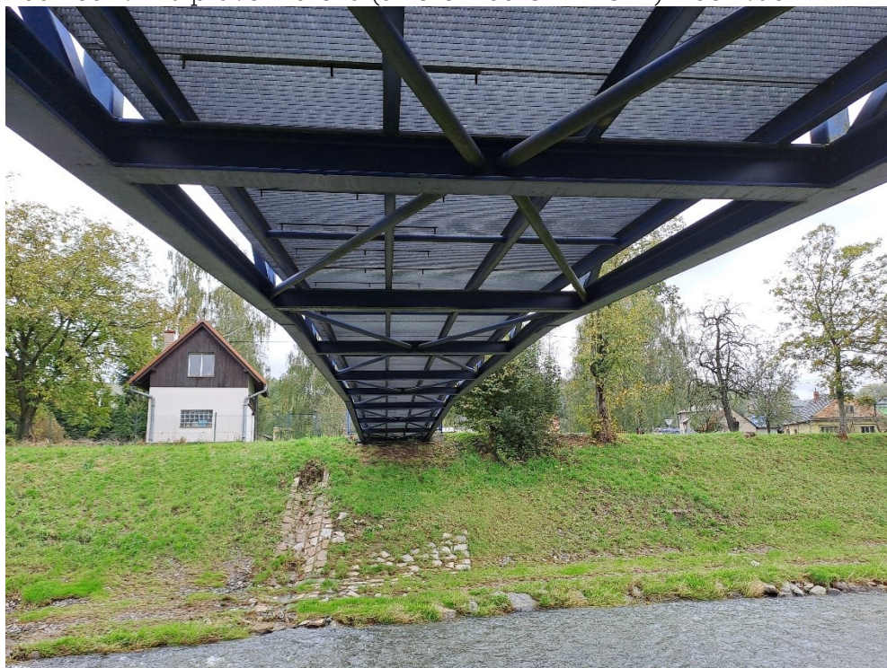
Podhled NK na pravém břehu (směrem od OP1 k OP2) – bez vad
