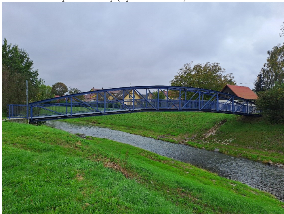
Pohled na NK z povoní strany (z pravého břehu)
