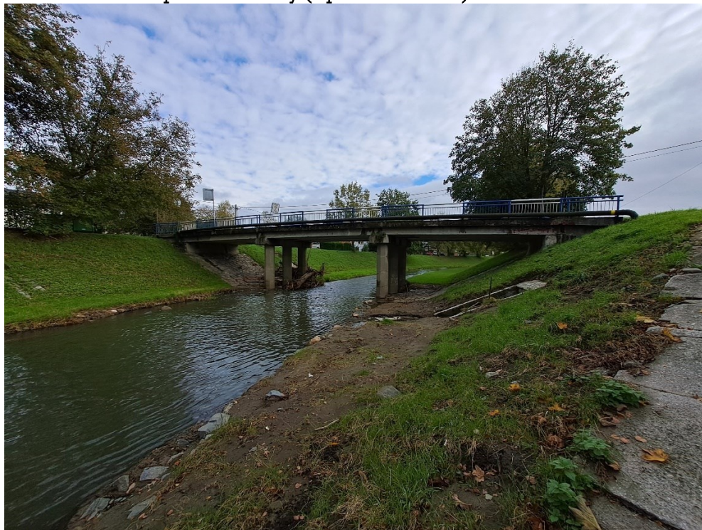
Pohled na most z povodní strany (z pravého břehu)
