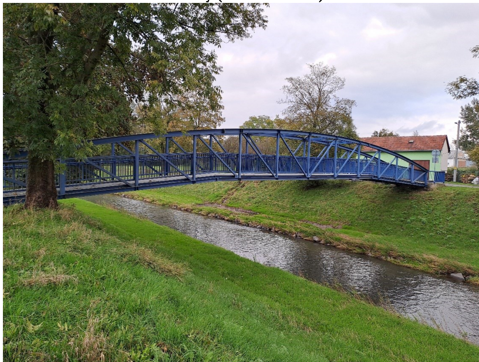
Pohled na most z návodní strany (z levého břehu)
