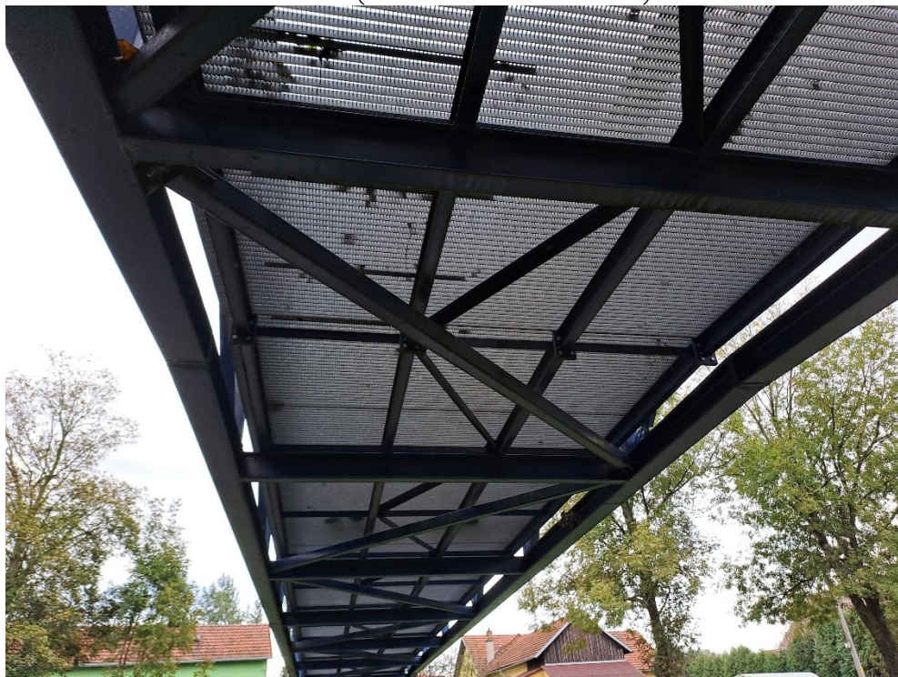
Podhled NK na levém břehu (směrem od OP2 k OP1) – bez vad
