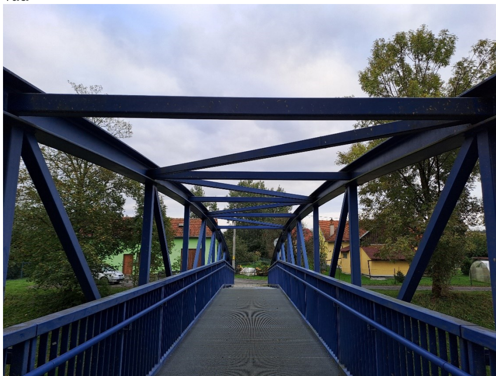
Pohled na ztužení horních pásů příhradových nosníků NK (směrem od OP2 k OP1) – bez vad
