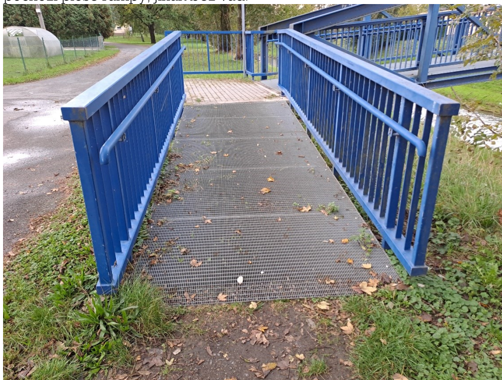
Pohled na přístupovou rampu navazující na pravé křídlo OP1 – lokálně vegetace na pochozí ploše rampy, jinak bez vad.
