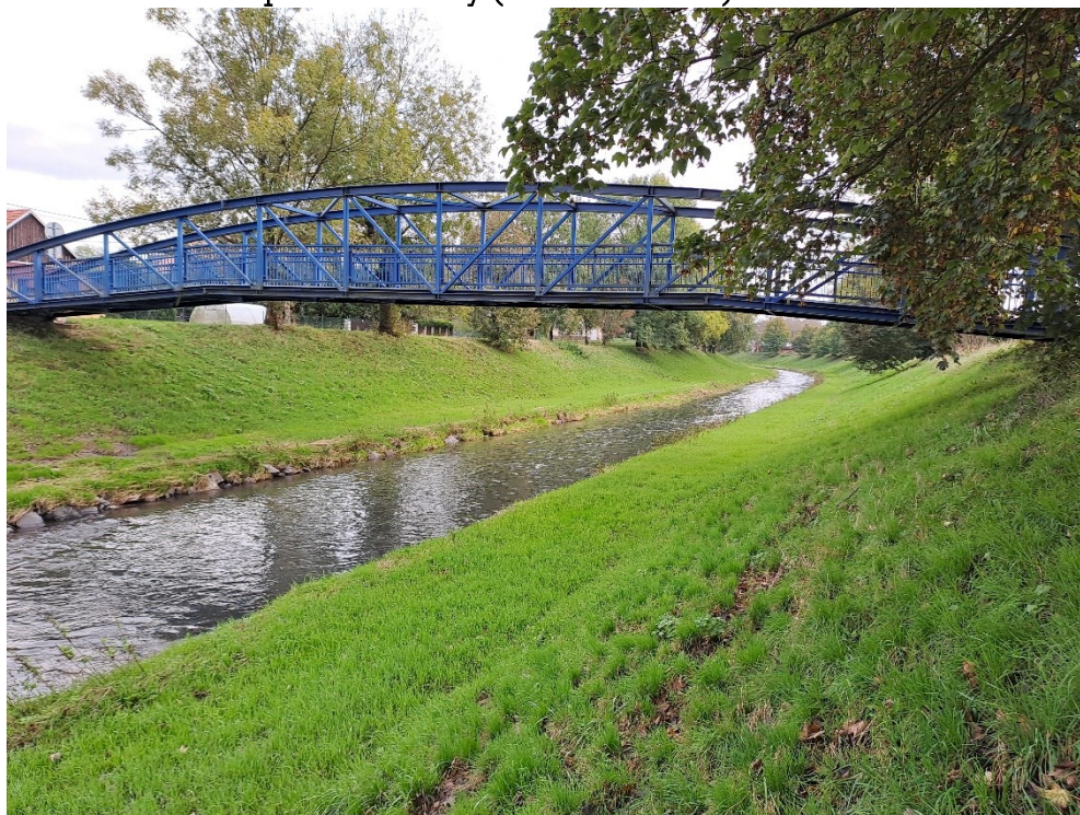
Pohled na most z povodní strany (z levého břehu)
