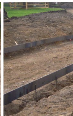
OCELOVÝ OBRUBNÍK (FOTO Z REALIZACE)
