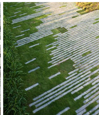
PŘECHOD ZPEVNĚNÉ PLOCHY DO TRÁVNÍKU
