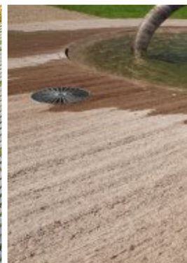
PROBARVENÝ BETON S PROTISKLUZOVOU ÚPRAVOU
